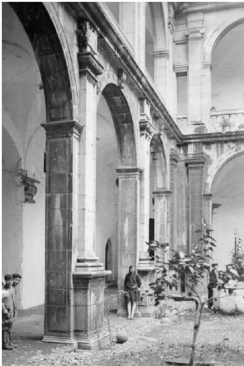
[Patio del Alcázar de los Duques de Feria, antigua sede del Instituto Libre de Zafra. 1928. Autor: Antonio Passaporte. Fotografía cedida por la FOTOTECA DE ZAFRA creada y gestionada por Manuel Méndez]
